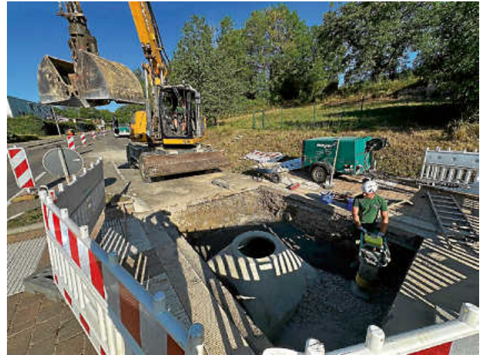
Schacht Kirchheimer Straße
