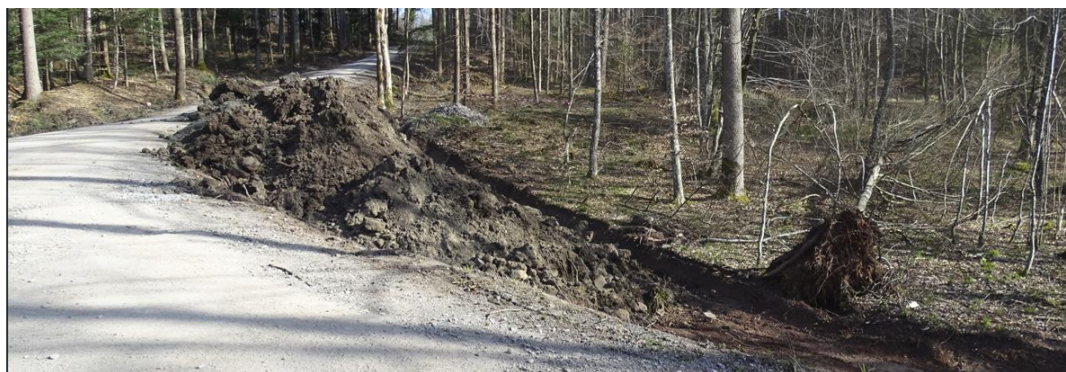
Waldweg während der Bauphase
