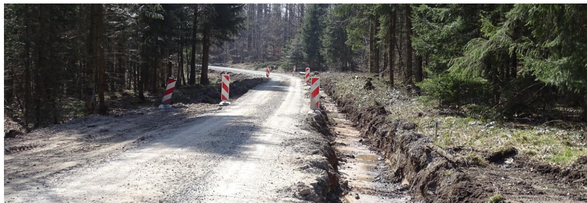
Waldweg während der Bauphase inkl. Kabelgraben
