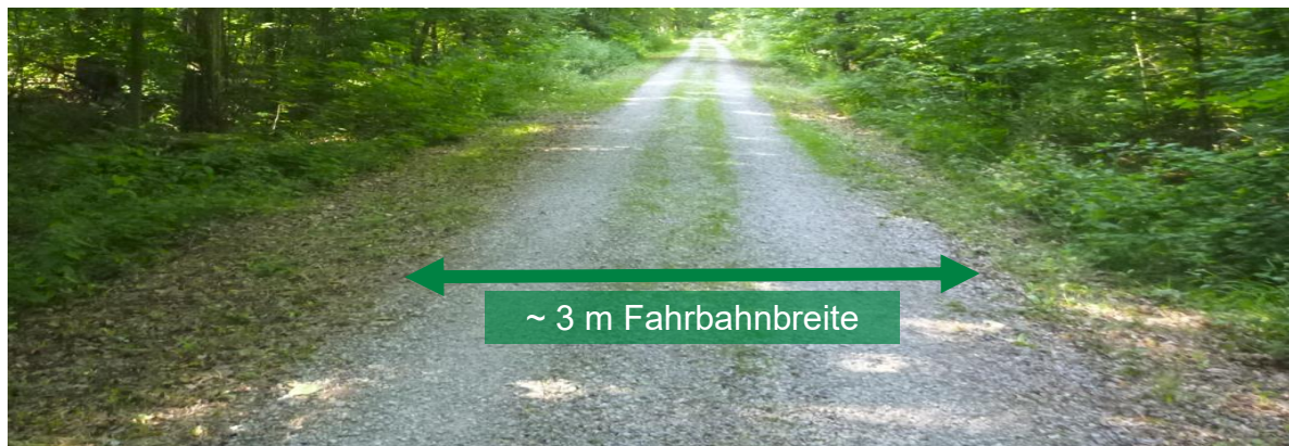
Waldweg vor dem Ausbau
