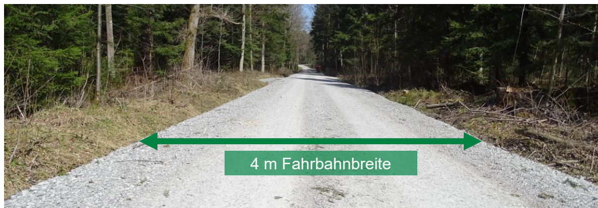
Waldweg nach dem Ausbau
