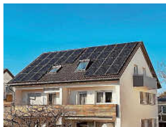
Saniertes Mehrfamilienhaus und Photovoltaik auf dem Dach
